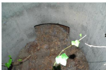
Afbeelding 38. De binnenzijde van de buis nog gevuld met zand en bladeren, bij de opening is de metalen plaat zichtbaar die de toegang aan de buitenzijde afsloot (foto: L. van Midden).
