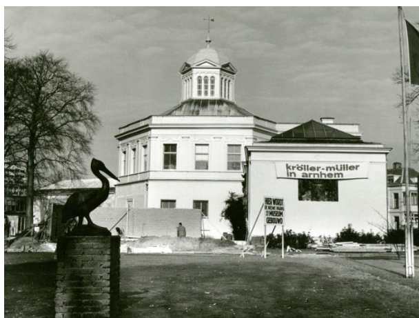
Afbeelding 32. Bouw aan de oostzijde van het museum, nabij de westelijke van de twee bunkers in de tuin (bron afbeelding: GldA, 1583 - Fotocollectie voormalig gemeentearchief Arnhem 2) .
