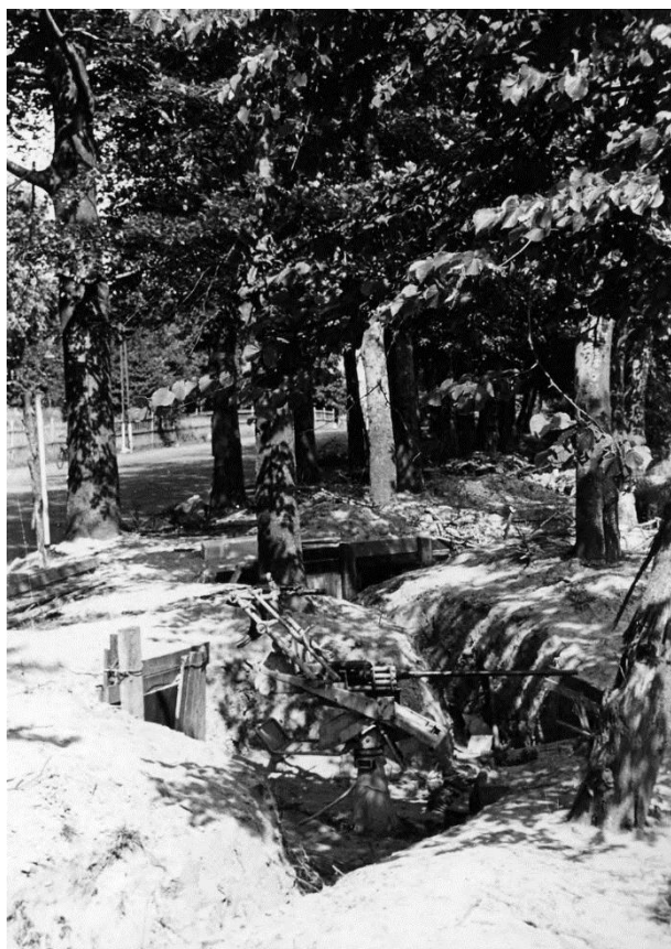
Afbeelding 28. Een na de bevrijding verlaten loopgraaf met machinegeweerpost langs de Utrechtseweg, ter hoogte van de westelijke bunker. Mogelijk hadden de verdedigingswerken in de museumtuin ook een dergelijk uiterlijk (bron afbeelding: GldA, 1560 - Fotocollectie Tweede Wereldoorlog 2776).
