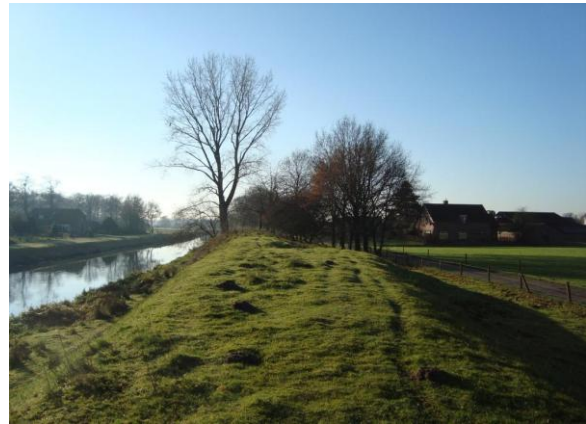
de Liniedijk richting zuiden
