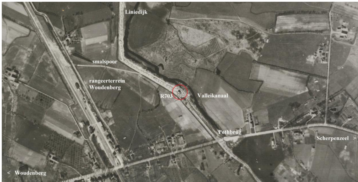
luchtopname van 8 april 1945; het Valleikanaal loopt in tegenstelling tot de huidige situatie in een grote bocht om de bunker heen; rechtsonder ten zuidoosten van de Pothbrug een geïnundeerd stuk terrein
