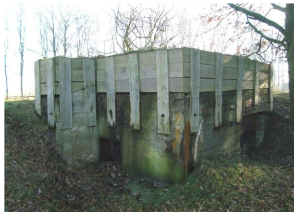
Nederlandse flankerende betonkazemat; schietgat voor een mitrailleur midden onder
