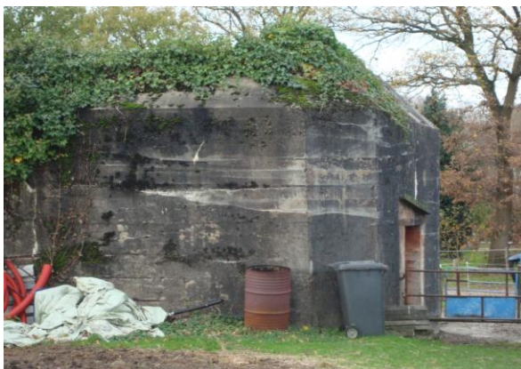
ook hier is de betonnen goot nog aanwezig
