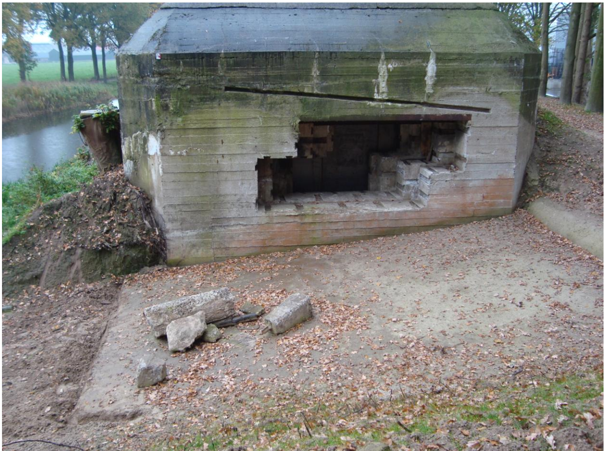
Pothbrug Woudenberg; linksonder betonresten, gevonden bij de uitgraving. Het schietgat heeft unieke (alleen hier aangetroffen) ingestorte latten voor de bevestiging van scherfwerende betimmering
