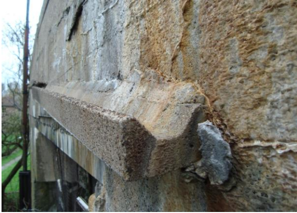
de vloeistofgoot boven het schietgat
