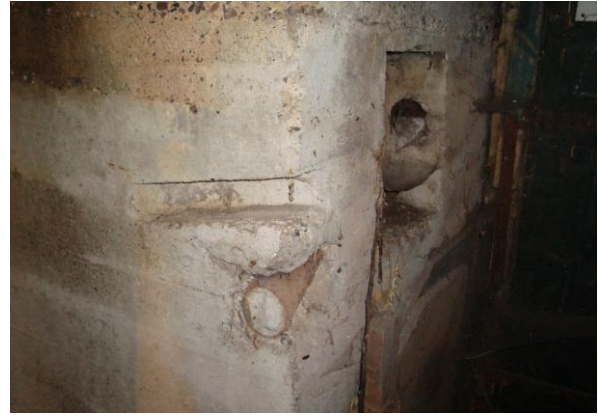
standaard doorvoerbuis met daarboven een kas
