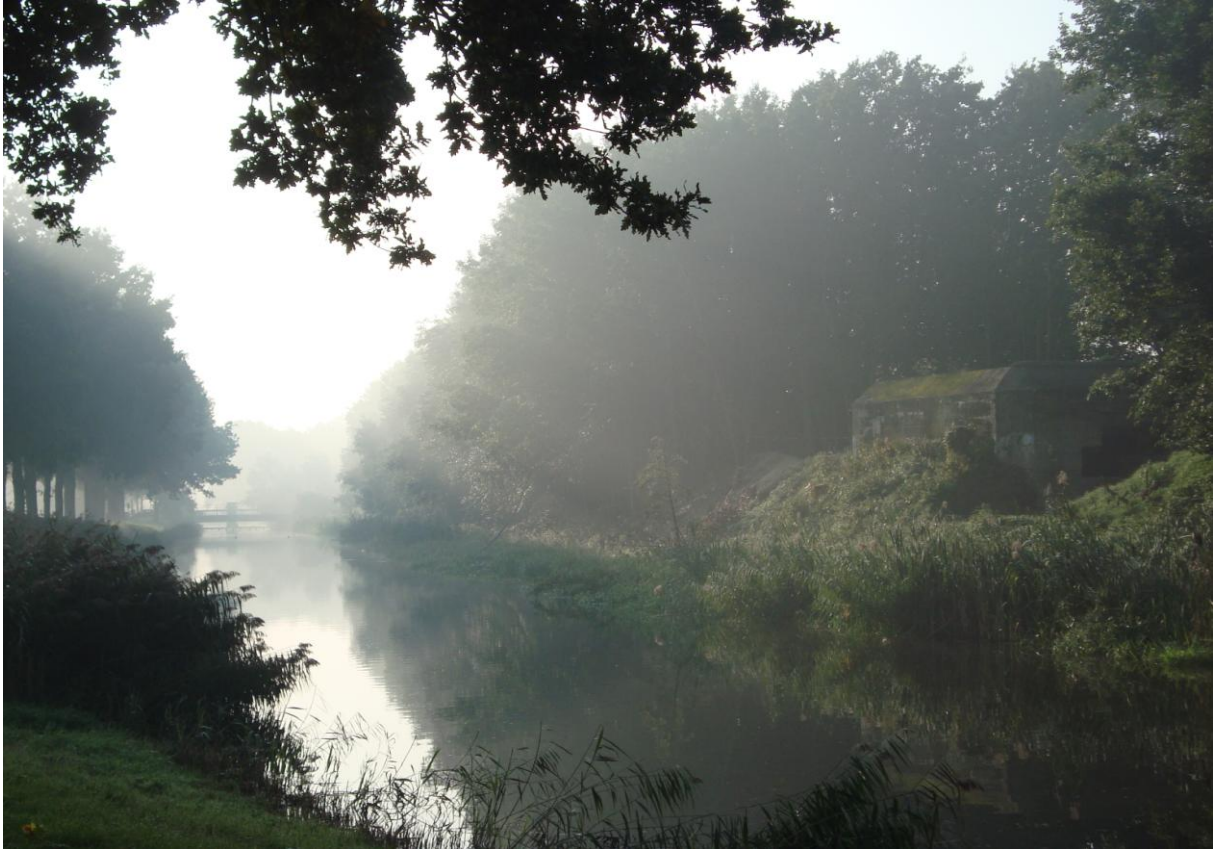
rechts laatste blik op de bunker; in de verte de Pothbrug en de damsluis daar achter
