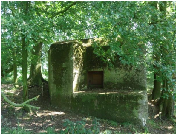
verderop een flankerende betonkazemat
