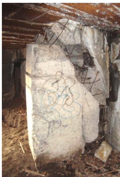
de ontzette tussenwand
