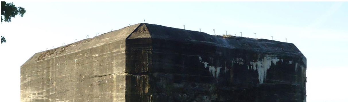
R703 Harsloweg; en het lag in de bedoeling dat ook de bunker Rijnsteeg zo gebouwd had moeten worden. Het dak is langs de omtrek voorzien van haken, vermoedelijk voor de bevestiging van camouflagenetten.
