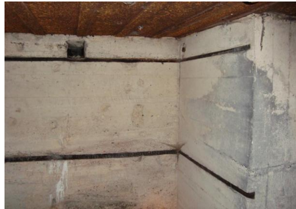
de munitieruimte met de ingestorte latten en zo'n merkwaardige kas hoog in de wand
