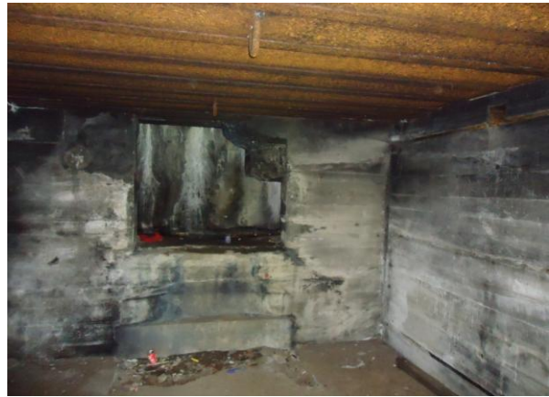
binnenzijde, vuurbanket verwijderd
