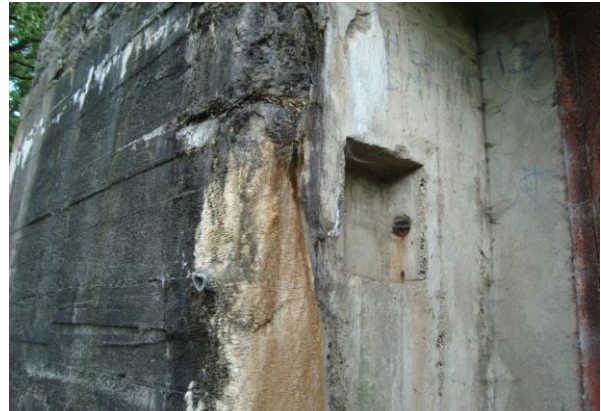
buis en sparing tbv communicatie met binnen; de buis \varnothing 80 mm mondt standaard binnen linksboven tegen het plafond uit.
